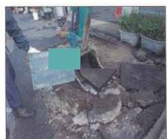
ガラ・残土積込状況
