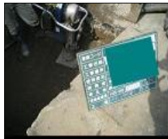
下層路盤転圧状況
