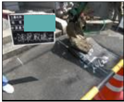
舗装取り壊し
