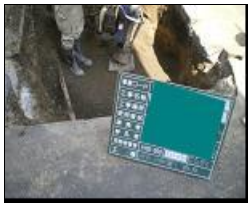
路床転圧状況
