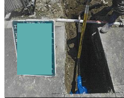
給水管引込状況
