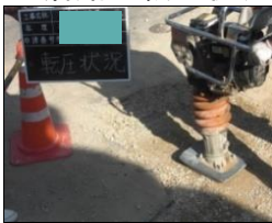
上層路盤転圧状況
