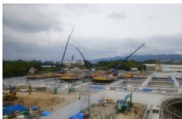
浄水施設の耐震化工事
