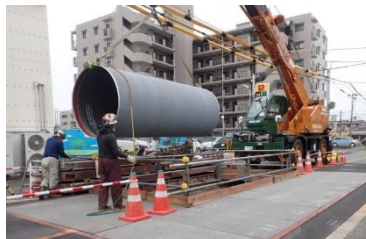
基幹管路の耐震化工事
