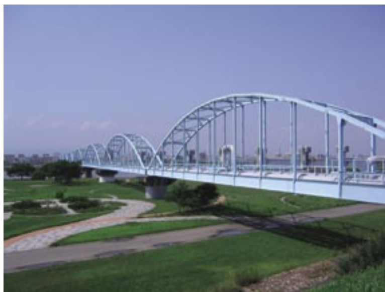
水管橋(長柄共同橋)
