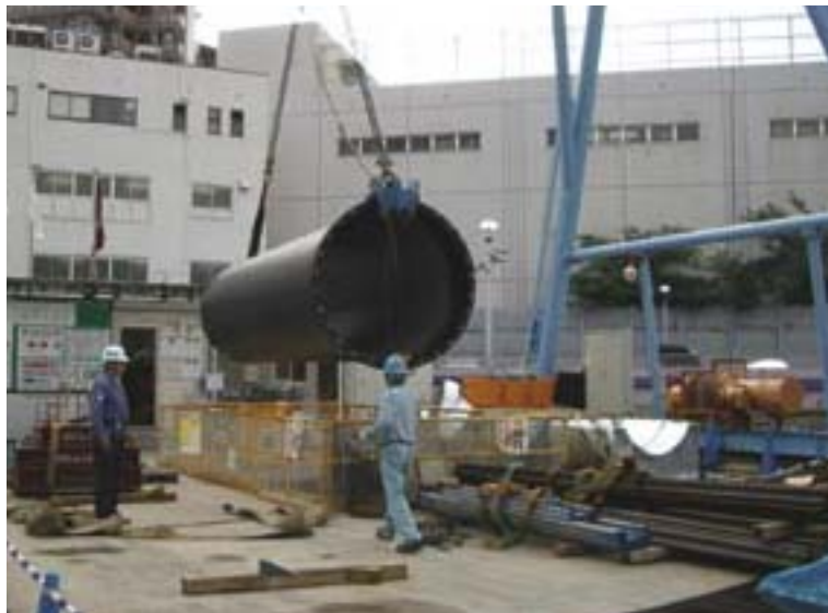
配水管整備事業
