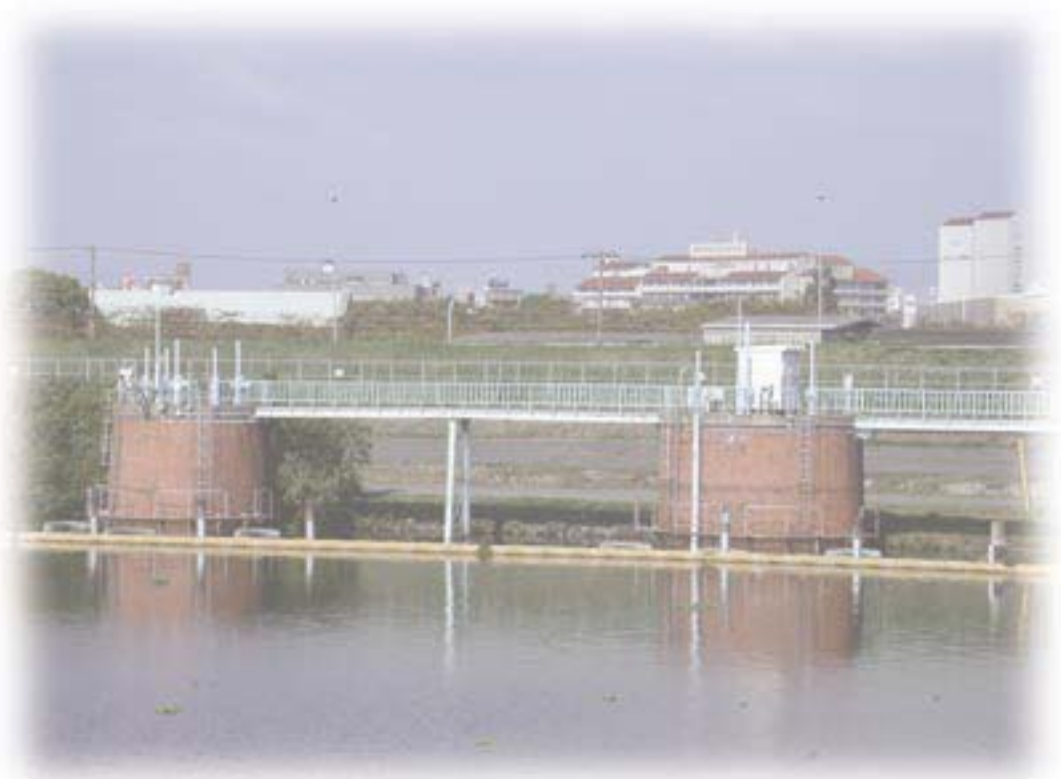
柴島浄水場 取水塔
