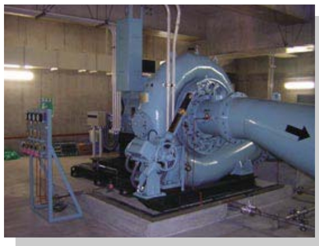
長居配水場 水力発電設備
