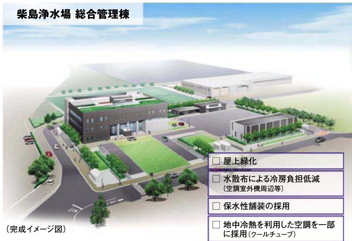
図5-6 本市水道施設を活用したヒートアイランド対策モデル事業
