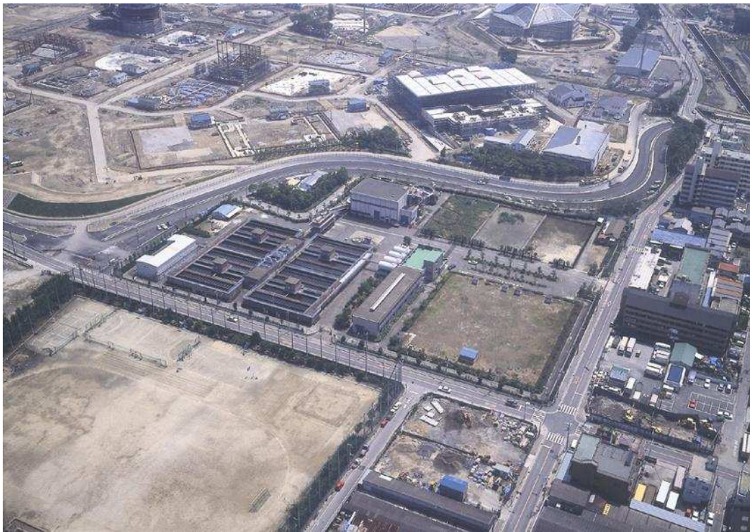
工業用水道城東浄水場 大阪市鶴見区横堤 4 丁目 29 - 60
