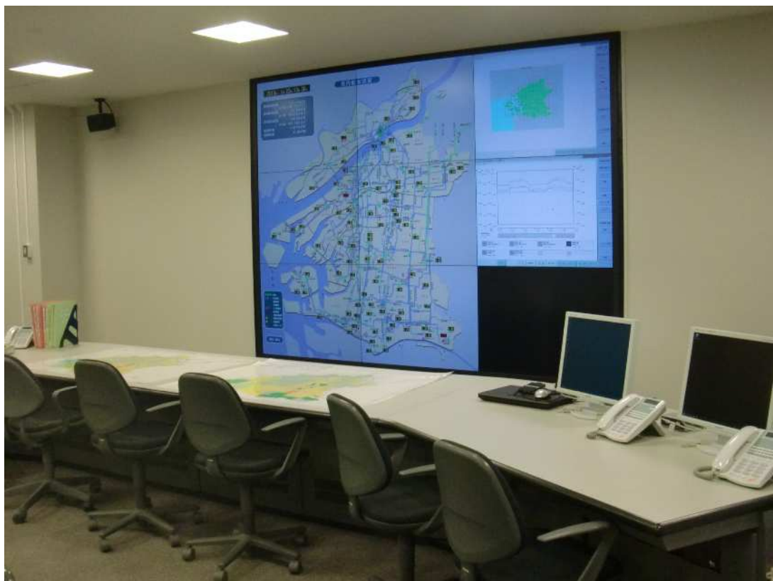
配水情報センター（水道局庁舎内）
