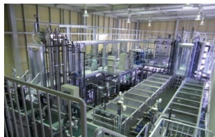
最適先端処理技術実験施設 内部
