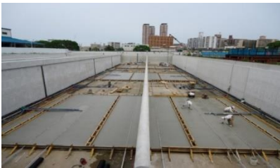
浄水施設（凝集沈澱地）の耐震整備 （庭窪浄水場）
