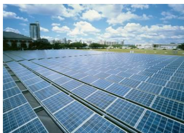
柴島浄水場太陽光発電設備
