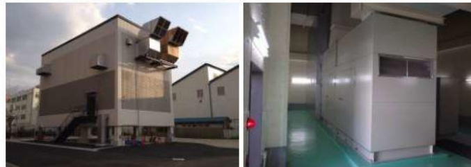
施設運転用自家発電設備の整備 （大淀配水場）
