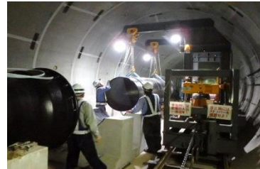
送配水ネットワークの強化 （共同溝内への配管）
