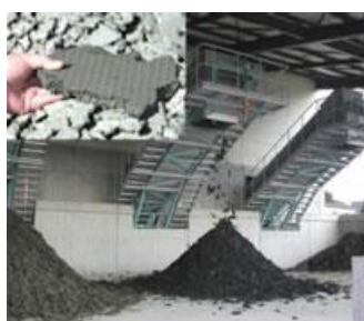
浄水発生土：機械脱水方式 (柴島、庭窪浄水場)
