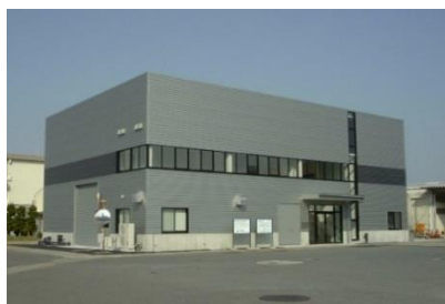
最適先端処理技術実験施設 外観
