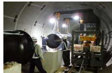
送配水ネットワークの強化 （共同溝内への配管）
