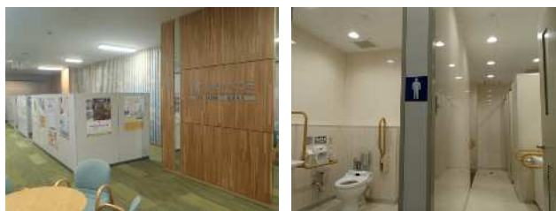
LED化により省電力化した庁舎や事業所
