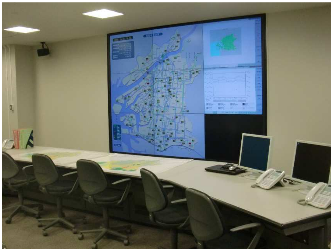
配水情報センター（水道局庁舎内）
