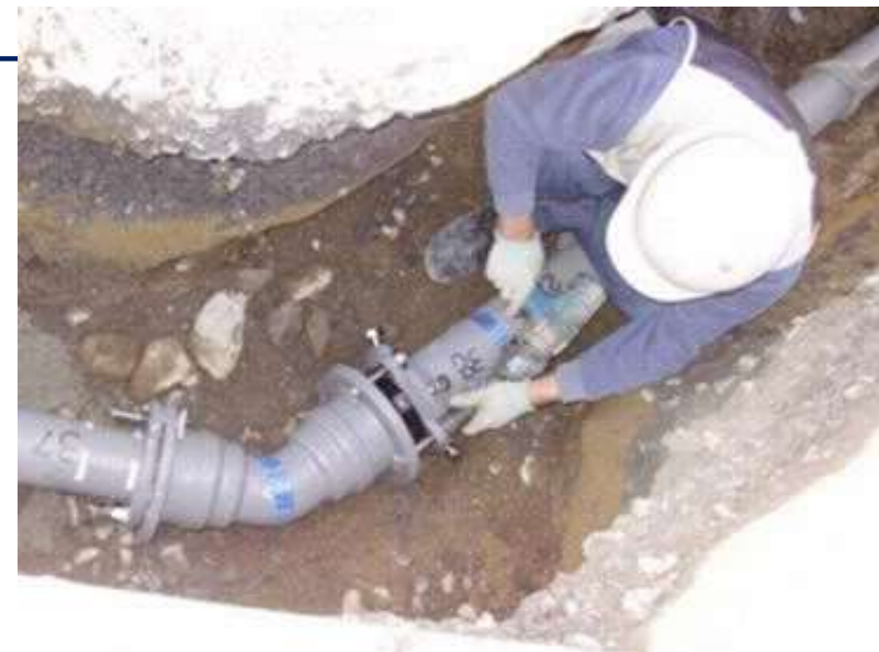
配水支管工事の施工
