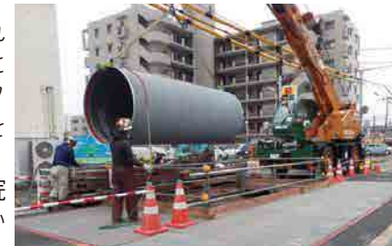
巽第1送水管の耐震化
