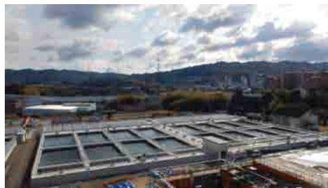
耐震化が完了した豊野浄水場の浄水施設
