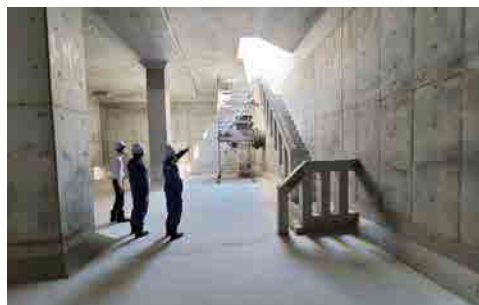
耐震化が完了した柴島浄水場上系の配水池
