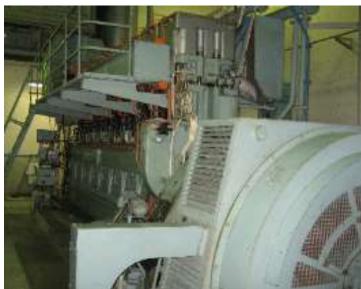
図表2-9 施設運転用自家発電設備(巽配水場)
