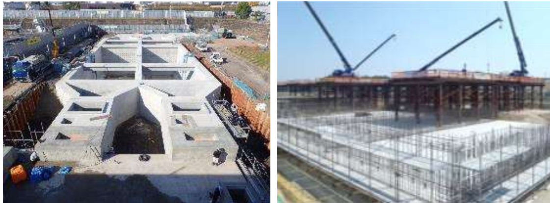
図表3-2 楠葉取水場(左側)および豊野浄水場(右側)の耐震化工事状況
