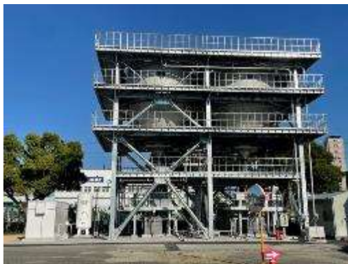
図表3-14 粉末活性炭注入設備(庭窪浄水場)
