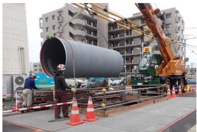
管路の耐震化工事（巽第1送水管）
