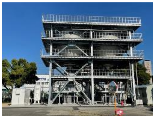
図表3-14 粉末活性炭注入設備(庭窪浄水場)
