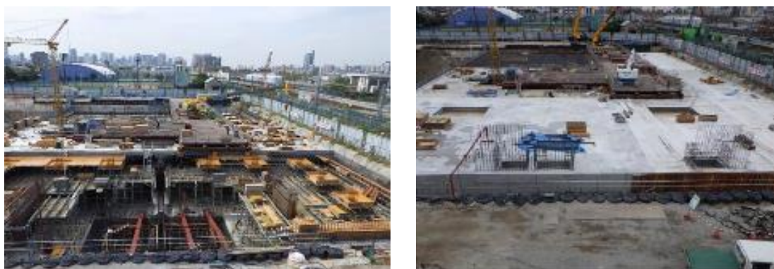
図表3-3 柴島浄水場上系配水池の耐震化工事状況
