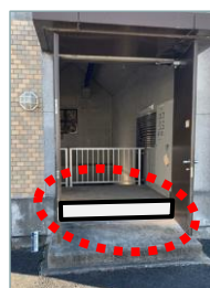
コンクリート壁設置
