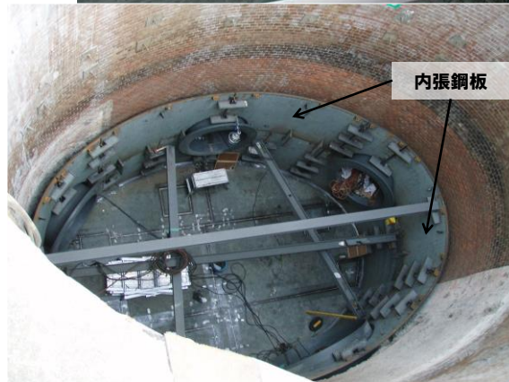
取水塔改良工事 施工状況
