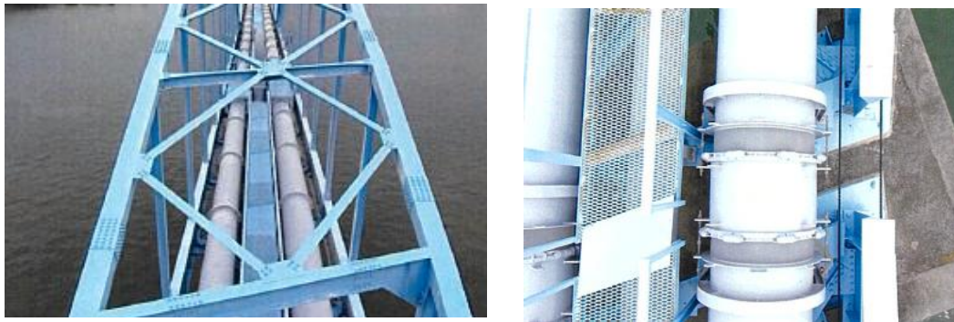
図表5-4 ドローンによる点検画像例(補剛材あり独立水管橋)
