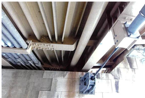
図表5-5 ドローンによる点検画像例(橋梁添架管)
