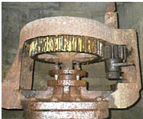
図表6-3 不断水修繕工事前
