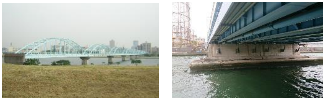
図表2－3 水管橋の一例(補剛形式の独立水管橋と橋梁添架管)
