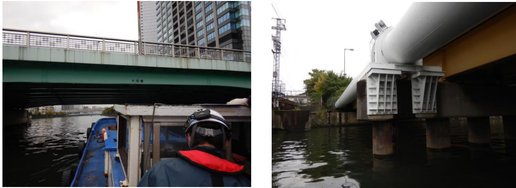
図表5-3 船上からの目視点検風景と点検状況
