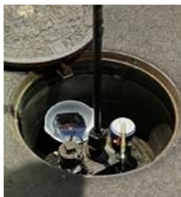
〈水圧調査の状況〉
