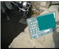
下層路盤転圧状況
