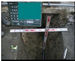
配管布設状況
