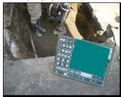
路床転圧状況
