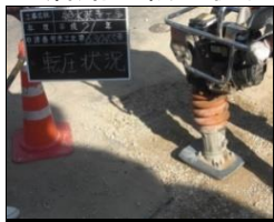
上層路盤転圧状況
