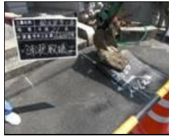
舗装取り壊し
