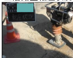
上層路盤転圧状況
