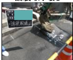
舗装取り壊し
