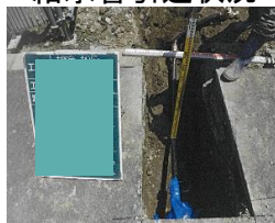
給水管引込状況
