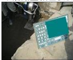
下層路盤転圧状況
