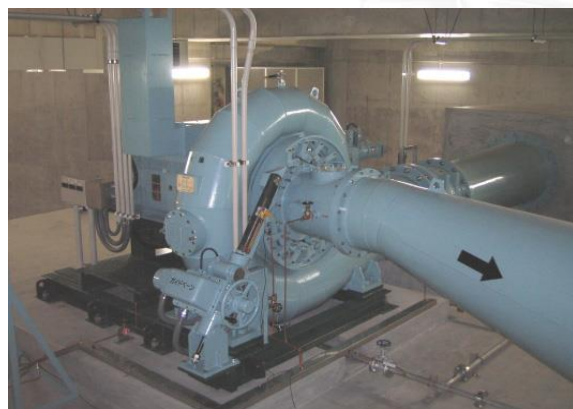
小水力発電設備（長居配水場）
