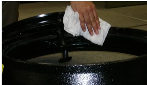
受枠清掃状況
