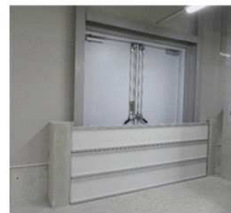
〈施設の耐水化事例(止水板の設置)〉
