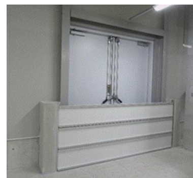
〈施設の耐水化事例(止水板の設置)〉
