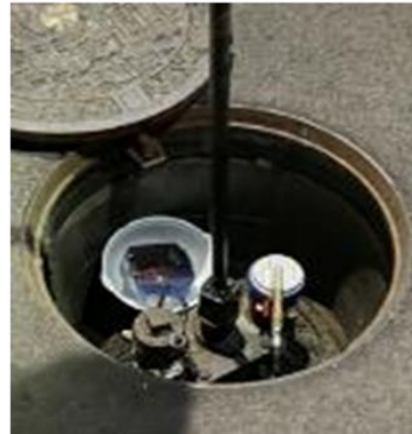
〈水圧調査の状況〉
