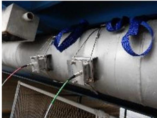
〈超音波流量計の設置状況〉
