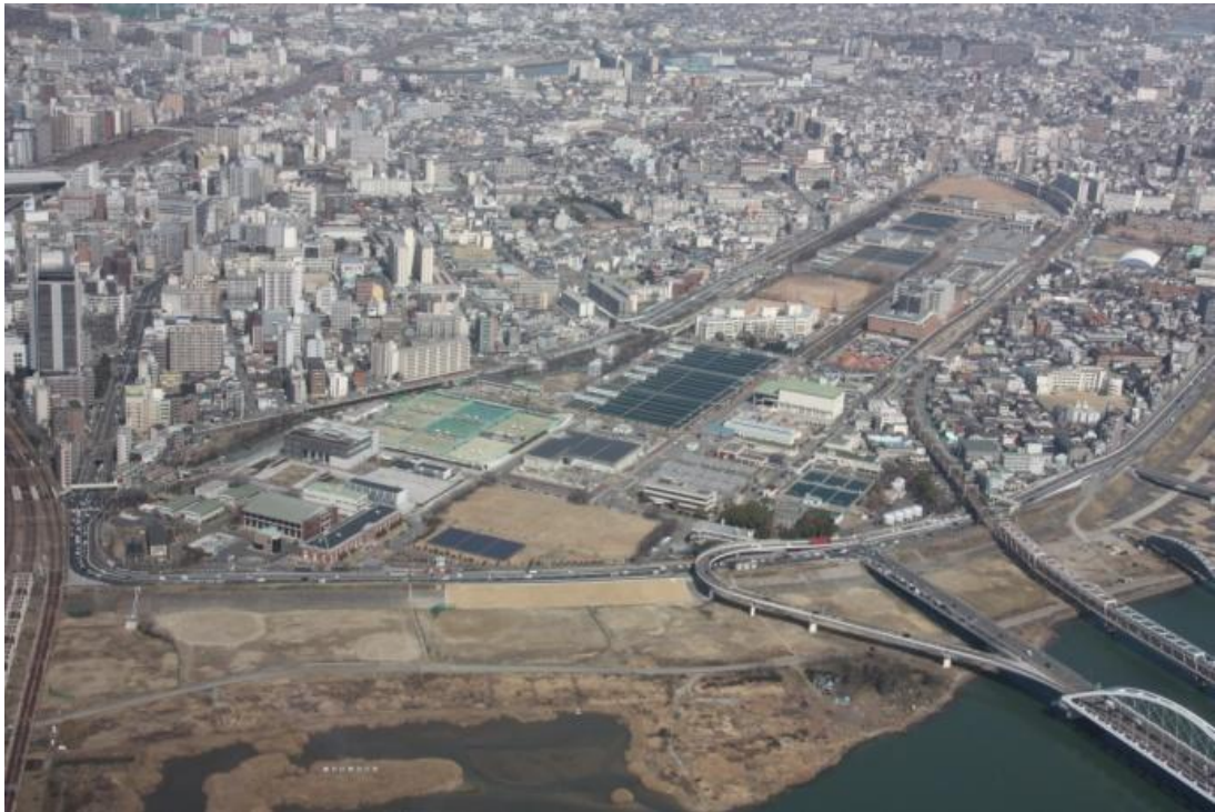
柴島浄水場 大阪市東淀川区柴島 1 丁目 3-14
