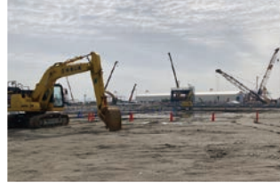
建築工事の様子
