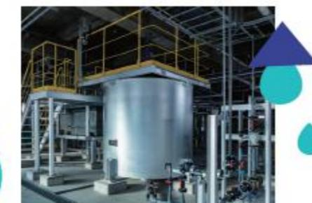
排水は凝集沈殿及びろ過を行い、再利用しています。
