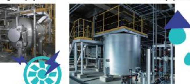
排水は凝集沈殿及びろ過を行い、再利用しています。
