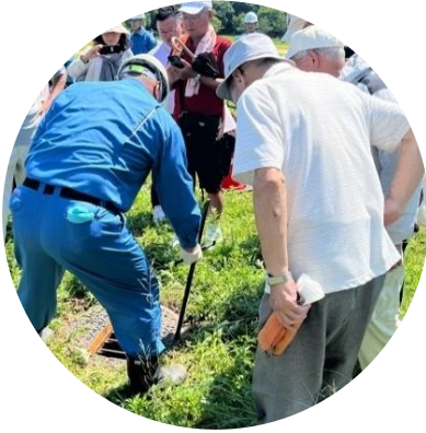
マンホールトイレ 設置訓練
