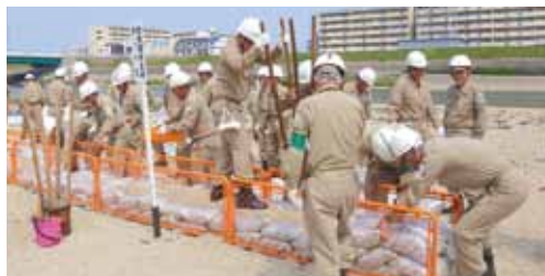
頑丈な改良越水止めネット工訓練。越水を土のうで的確に食い止めるために開発されました
