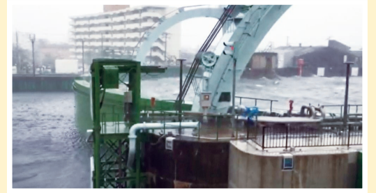
平成30年台風第21号 接近時の木津川水門
