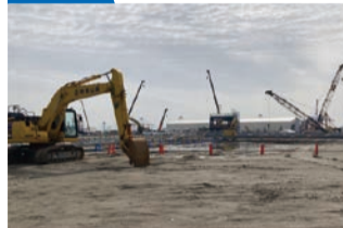
建築工事の様子
