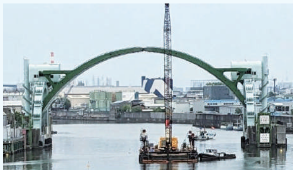
工事の施工状況
