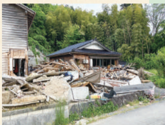
倒壊した家屋
