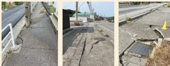
大屋小学校の周辺道路
