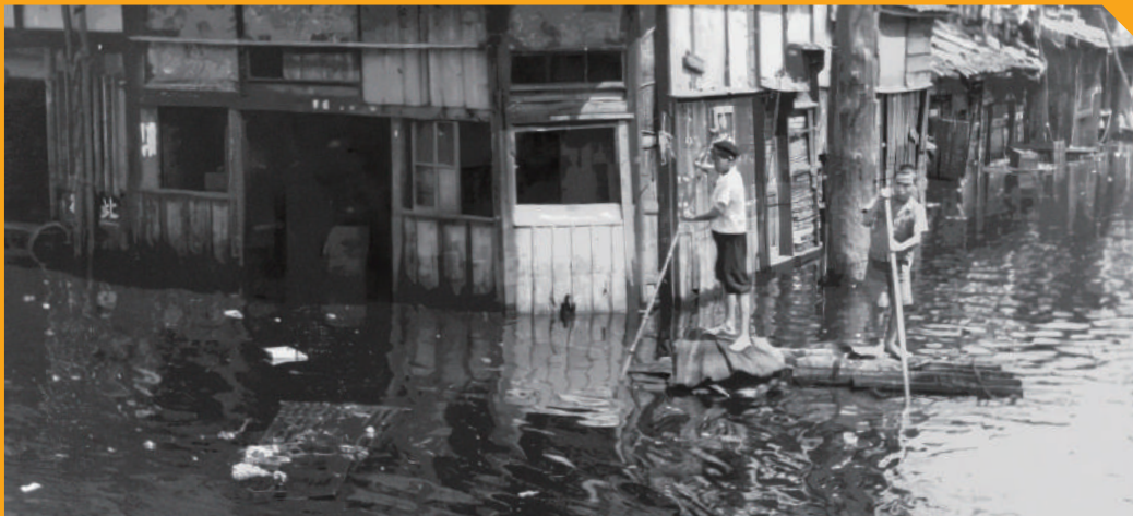
昭和25年(1950年) ジェーン台風「大正区の浸水状況(大正警察署から)」
