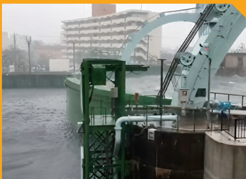
平成30年(2018年) 台風21号による高潮に耐える木津川水門
