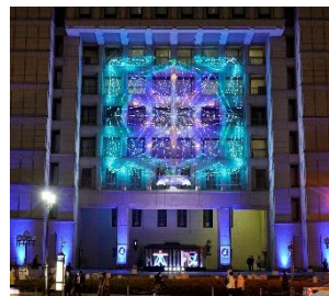
大阪市役所正面イルミネーション ファサード・フォトモニュメント
