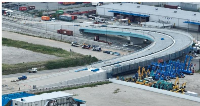
(仮称) 夢洲北高架橋主桁架設完了 (R6年5月時点)
