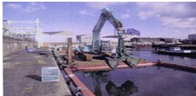
浚渫船による汚染底質の除去
