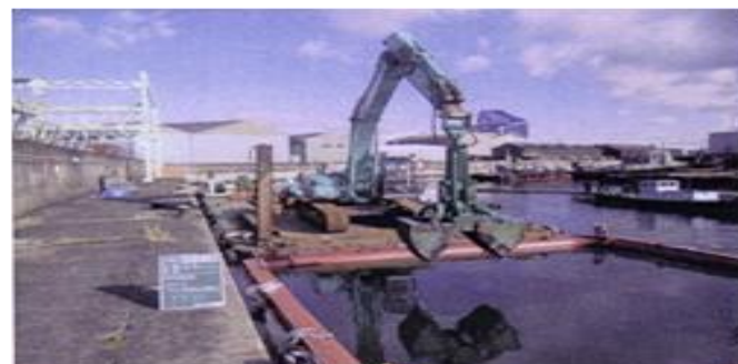
浚渫船による汚染底質の除去
