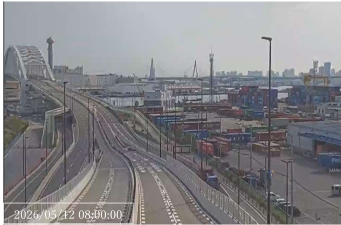
・夢舞大橋の状況
