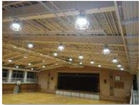
<脱落対策後> 天井撤去による対策
