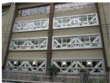
ブレース設置（窓面）
