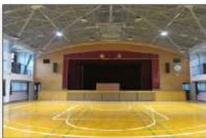
ブレース設置（屋根面）
