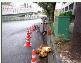
写真 腐朽菌侵入による倒木事故
