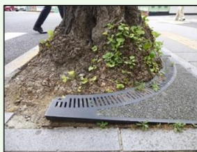
写真 大木化による根上り
