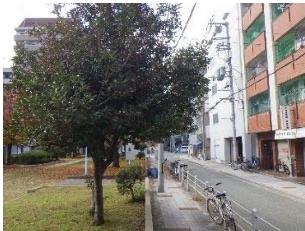
写真 架空線に干渉している樹木
