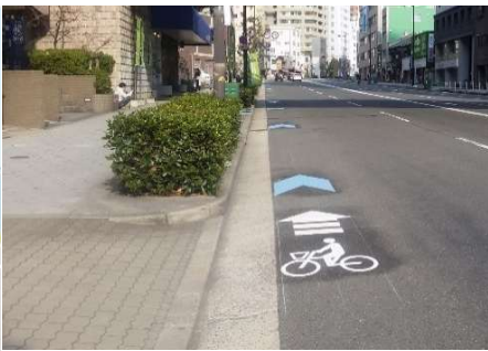
図表2-10. 自転車通行空間の整備 （左）河川空間を活用した自転車歩行者専用道路 （右）一般道における矢羽根型（標準形）路面表示
