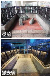
バルコニー部の石材撤去
