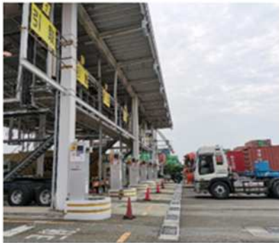
コンテナターミナルのゲート
