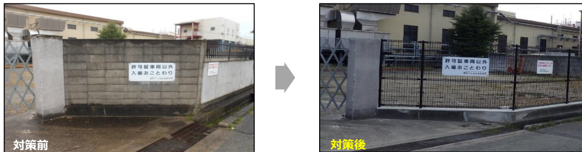
コンクリートブロック塀の改修
