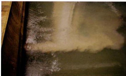
降雨初期の雨水が東横堀川へ放流される様子
