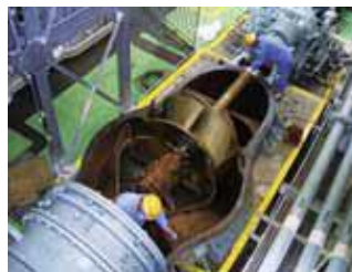
雨水ポンプの開放点検
