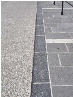
縁石に舗装と調和した色彩を用いることで、極力目立たないように工夫しています。(御堂筋・道頓堀橋南詰交差点付近)
